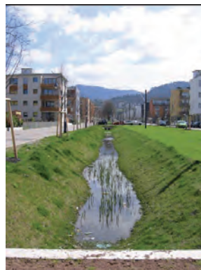
la Vauban Allee, noue de récupération des eaux de pluie
